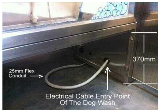
L'image ci-dessus montre le point d'entrée principal du câble électrique dans le lave-chien. Une fois que vous avez passé le câble et le conduit jusqu'à ce point, laissez un autre 900mm pour la terminaison à l'intérieur du boîtier.
