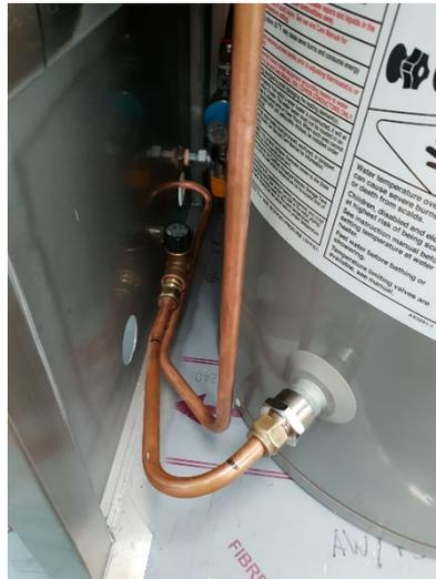
L'image ci-dessous montre le point d'entrée de l'eau pour un K9000 2.0 avec un service de stockage d'eau chaude.
